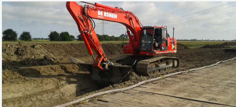
TenneT hat On- und Offshore bereits mehrere Tausend Kilometer See- und Erdkabel verlegt.
